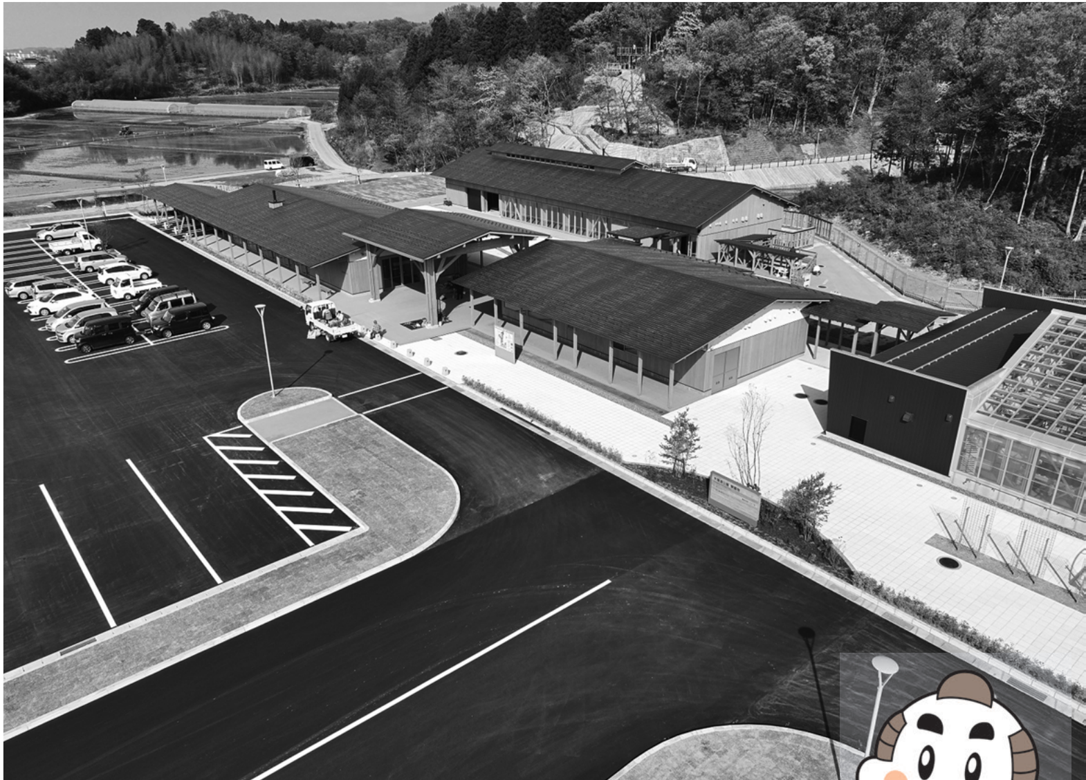
木場潟公園東園地 里山交流ハウス
