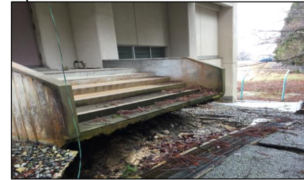
飯田高校（地盤沈下）
