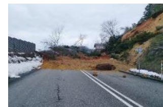
道路寸断（珠洲道路）
