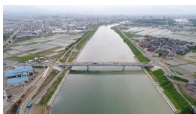
河川整備 (水害対策)
