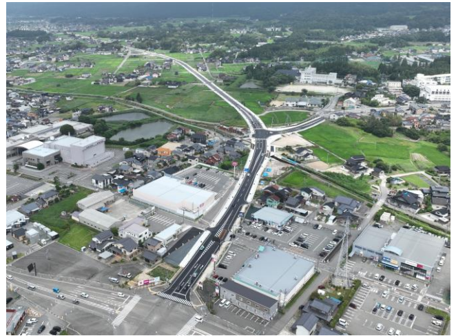
▲ 完成写真（古府町側から万行町側を望む）
