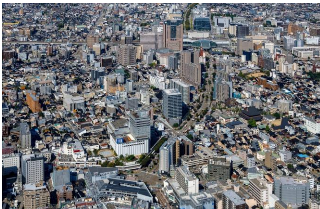
金沢駅通り線沿道：開発エリア
