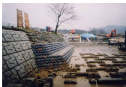
既設石積み護岸の景観を保全するため、 根固めにより補強 (大聖寺川／加賀市)
