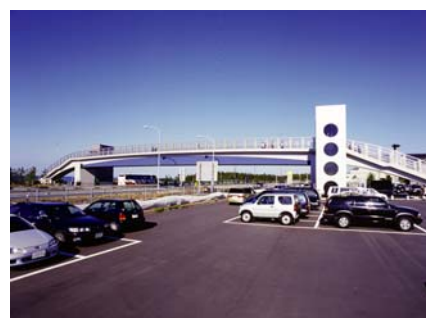
スレンダーな印象となるよう色彩を工夫し、防護柵は橋本体と調和するよう目立たないものを採用 (ラブリッジまっとう／白山市)
