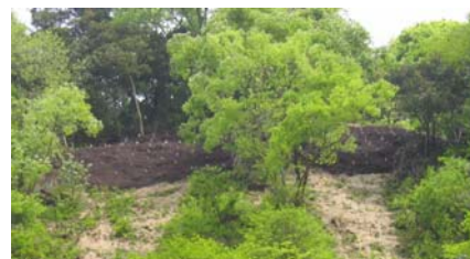
名勝地不動滝に隣接する山腹面を既存樹木を残してロープ連結型法枠により復旧（井田地区山腹／中能登町）
