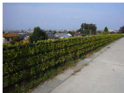
防護柵を緑化（山側環状／金沢市）
