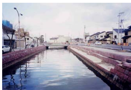
紅露石を布積みにして護岸を整備 (御祓川／七尾市)
