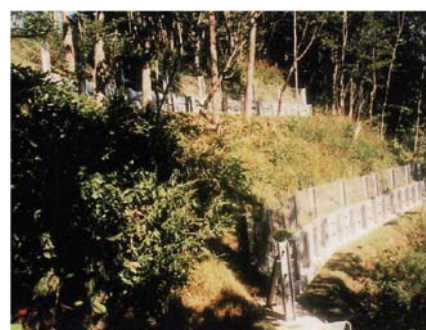
既存樹木を残して土留柵工を整備し、環境との調和、生態系の保全に配慮（市ノ瀬地区山腹／輪島市）
