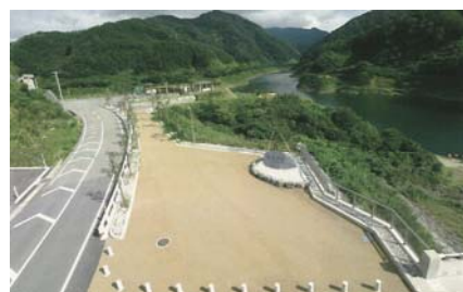
ダムサイト周辺に広場を整備 (九谷ダム／加賀市)
