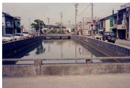
整備前 (老朽化したコンクリート護岸)
