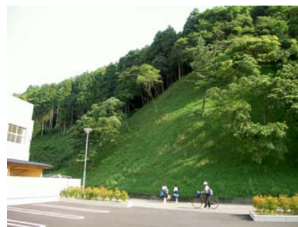
隣接する中学校との景観の調和に配慮し、連続繊維補強土工により自生立木を残存（清水地区山腹／輪島市）
