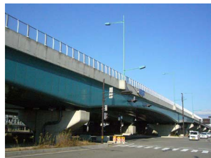
高架橋の橋桁や橋台・橋脚に曲線処理を施すことにより、圧迫感を軽減 (西念高架橋／金沢市)
