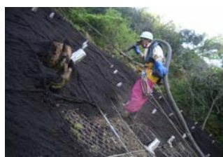
植生基材吹付工による緑化
