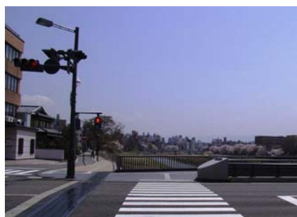
高欄は、犀川や医王山の眺望を確保するため見通しの良い多柵型を採用し、高欄、照明灯、信号柱をダークグレーで統一（御影大橋／金沢市）
