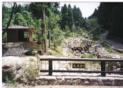
現地の自然石を取り入れて護岸を整備 (永光寺川／羽咋市)
