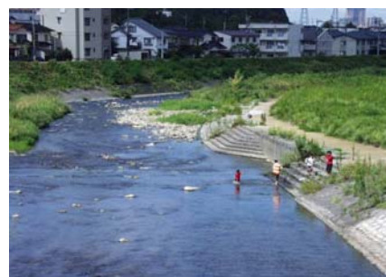
部分的に階段護岸を整備し、親水性を確保するとともに、単調な景観に変化を与えるよう工夫（浅野川／金沢市）
