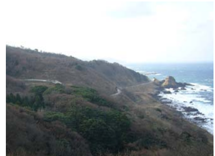
自然地形に配慮した道路線形を選定 (主要地方道大谷狼煙飯田線/珠洲市)
