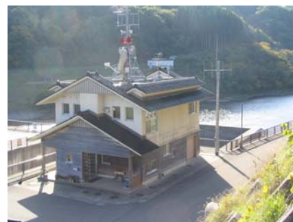
管理棟の屋根を瓦葺きとし、外壁に木材を使用して能登の民家をイメージ（小屋ダム／珠洲市）
