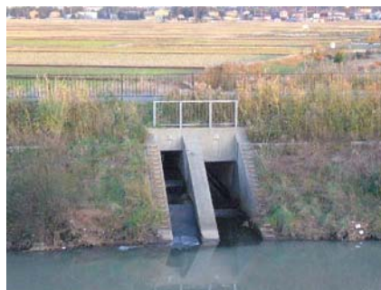
景観に配慮して突出しない構造を採用 (安原川／金沢市)
