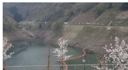
貯水池周辺に桜を植樹 (九谷ダム／加賀市)
