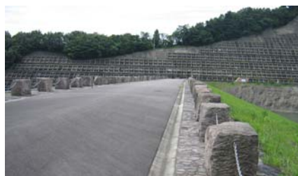
堤頂道路置き石に地場産材の戸室石を利用（医王ダム／金沢市）
