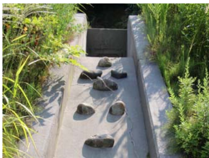
縦排水路の制水工に自然石を使用して自然との一体性に配慮 (主要地方道白山公園線／白山市)
