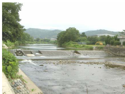
既存の堰を補修・補強することにより、昔からの景観を保存 (大聖寺川／加賀市)
