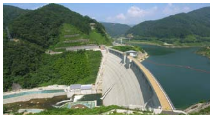
緩やかなアーチを描き、下流側壁面に筋を刻むことにより景観や地形に配慮（丸谷ダム／加賀市）
