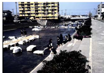
河川堤の緑化、階段護岸や飛石等の設置により、レクリエーションの場を創出（伏見川・高橋川／金沢市）
