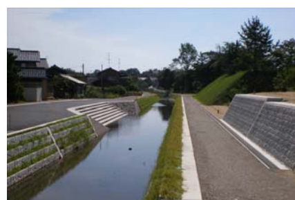
水際まで降りられる階段を整備（大谷川／かほく市）
