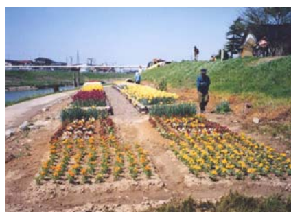
高水敷を花壇として利用し、近隣住民のふれあいの場として整備 (浅野川／金沢市)
