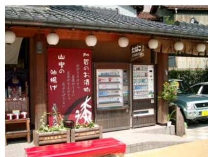
自動販売機を景観に配慮して修景 (都市計画道路温泉中央南線／加賀市)
