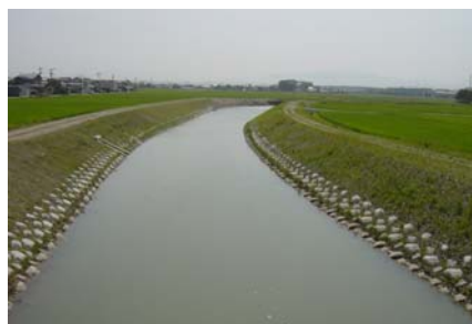
護岸肩部の硬い印象を和らげるよう、護岸天端付近を緑化 (倉部川／白山市)
