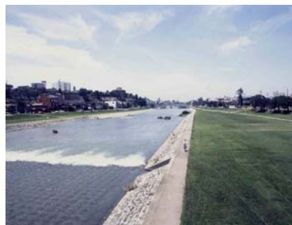
高水敷が緑地公園として整備され、レクリエーション等、多くの人々が利用 (犀川／金沢市)
