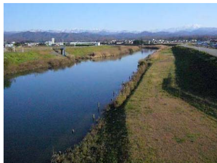
生態系に配慮して木工沈床を設置 (梯川／小松市)
