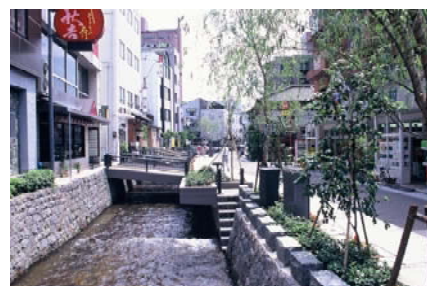
水路底へ降りられるような階段を整備 (鞍月用水／金沢市)
