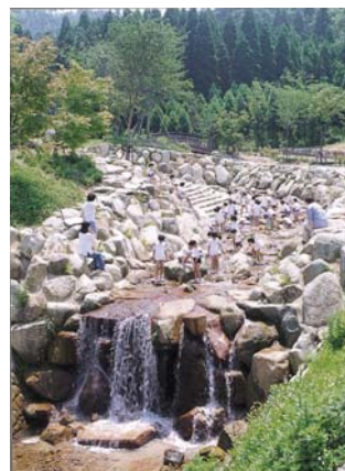
親水性を配慮した階段護岸を整備し、児童の環境学習活動などにも利用 (永光寺川／羽咋市)
