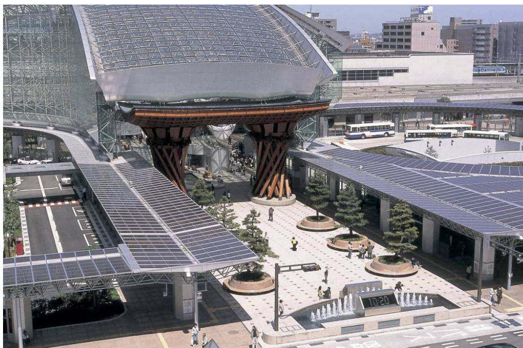
▲金沢駅東口広場の鼓門
