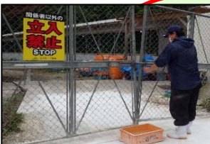
フェンス設置
