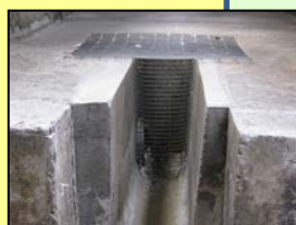
排水溝等からの侵入防止対策 (鉄格子の設置)
