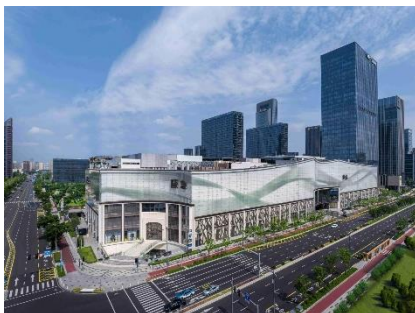
寧波阪急_外観
