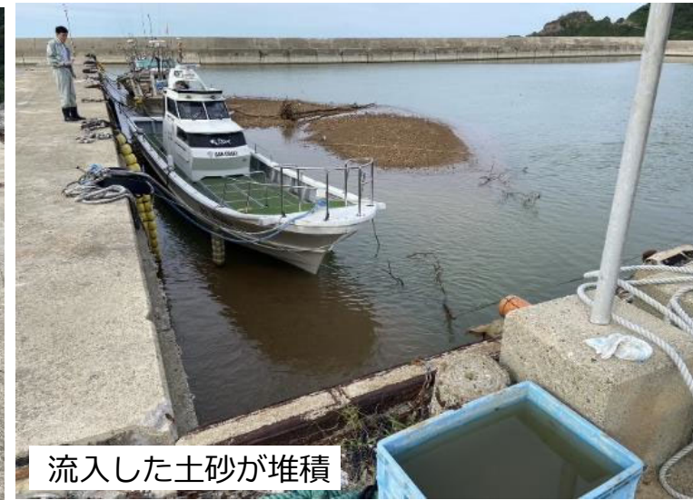
流入した土砂が堆積
