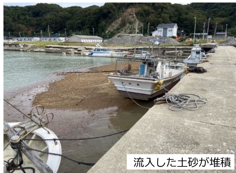
流入した土砂が堆積
