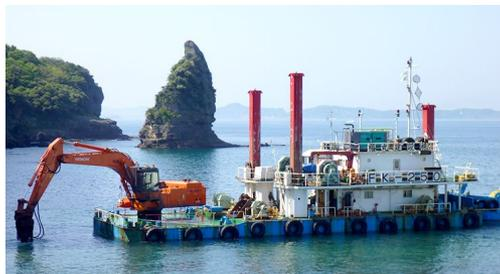
▼バックホウ浚渫船による掘削
