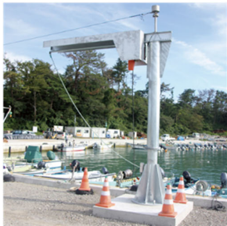
ジブクレーン
