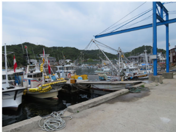
橋形クレーン
