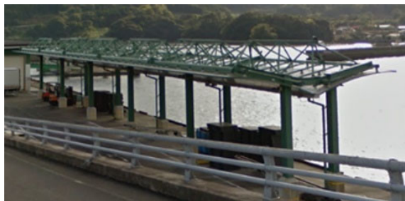
屋根付き岸壁
