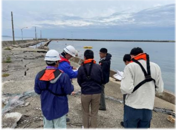
災害査定の状況
