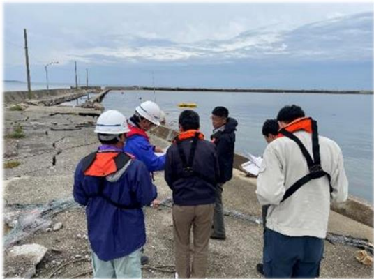
災害査定の状況
