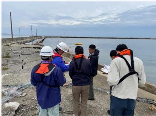
災害査定の状況
