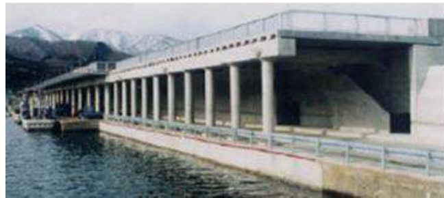
屋根付き岸壁（防風雪）
