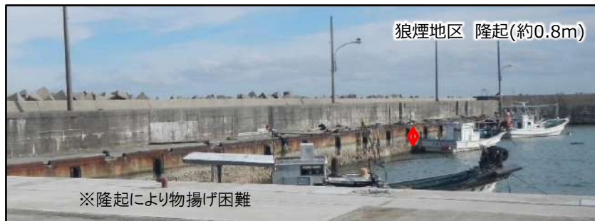
狼煙漁港（珠洲市）
