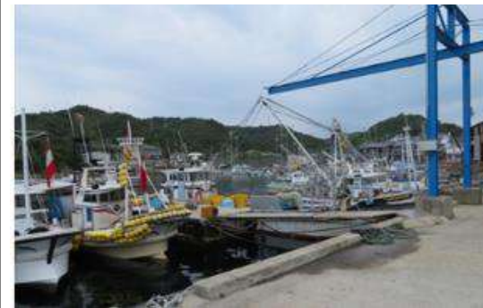
橋形クレーン
