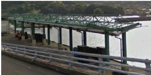
屋根付き岸壁
