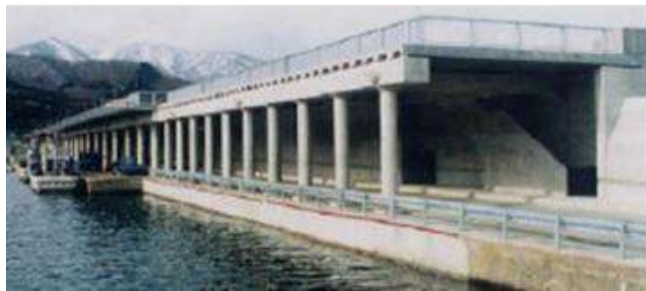
屋根付き岸壁（防風雪）
