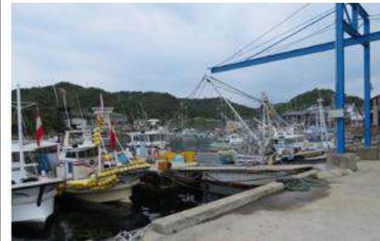
橋形クレーン
