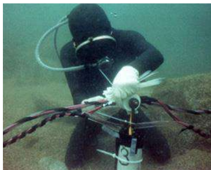
▲潜水士による爆薬装填
