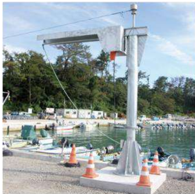
ジブクレーン
