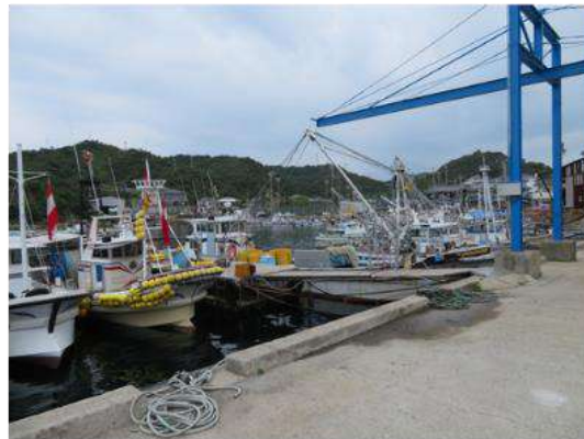
橋形クレーン
