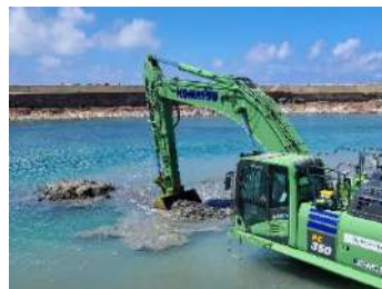
赤神漁港の仮復旧工事 (輪島市,8月)
