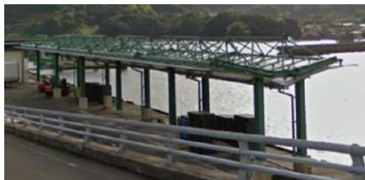
屋根付き岸壁
