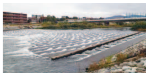
全断面魚道の整備
