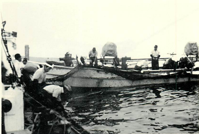
photo 8 取揚揚網作業
