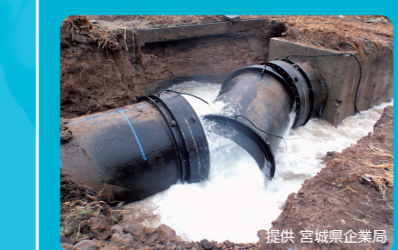
送水管の被害状況(平成23年東日本大震災)
