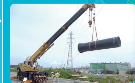
耐震管の布設状況
