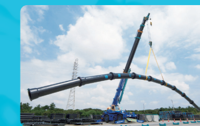
送水管の離脱防止テスト
