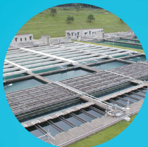
1 鶴来浄水場(沈でん池)
