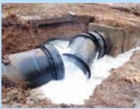
送水管の被害状況(平成23年東日本大震災) 提供 宮城県企業局
