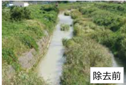
河川の堆積土砂除去
