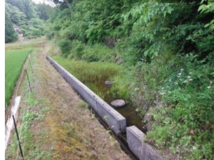
残地を利用したビオトープ
