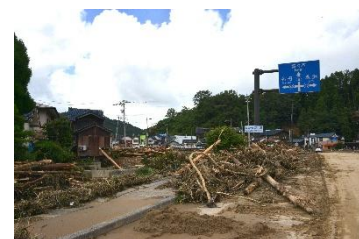
豪雨による被害
