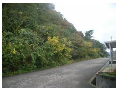
緩衝帯 整備前
