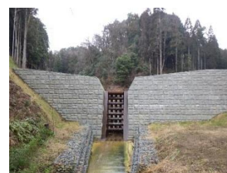
生態系に配慮した砂防堰堤
