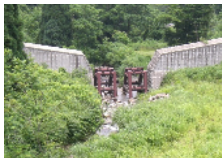
生態系に配慮した砂防堰堤
