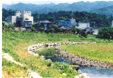
河原田川(輪島市) (瀬と淵の創出、巨石による水生生物への配慮)
