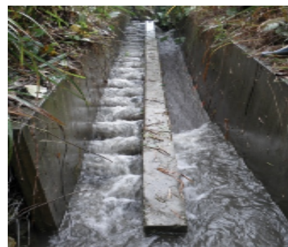
水路の落差工の改良
