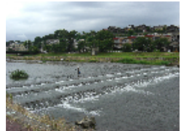
犀川(金沢市) (多段式落差工による水生生物への配慮)
