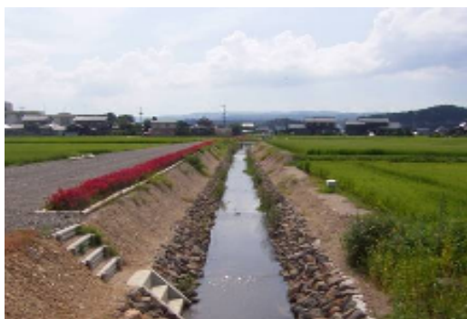
自然石による水路整備
