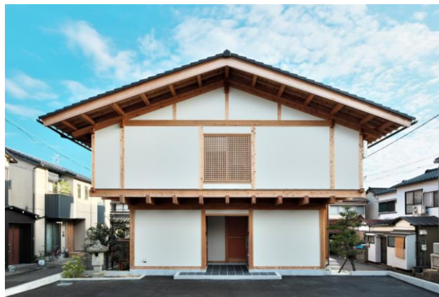
二世帯の大屋根の家【金沢市】
