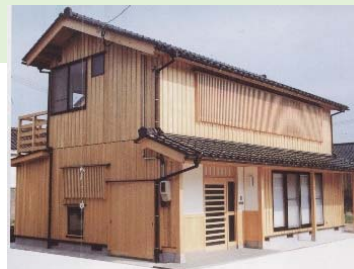
能登ヒバは独特の光沢や芳香を有し、強度や耐湿性にも優れている
