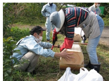
県産材ベンチの設置
