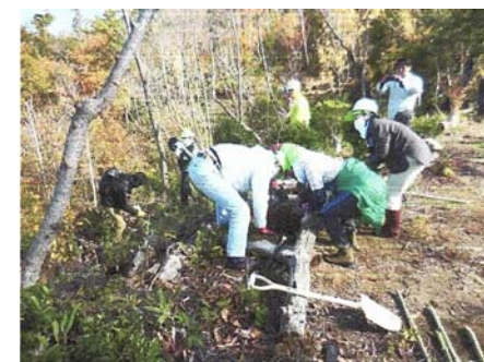
散策路の整備
