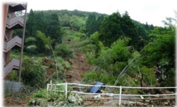
①土砂崩壊が発生した竹林の状況
