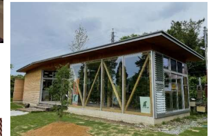
金沢森林組合 緑化木センター事務所棟
