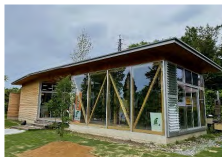
金沢森林組合 緑化木センター事務所棟
