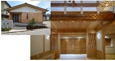
県産材利用住宅
