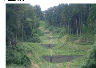
土砂流出危険地区の整備
