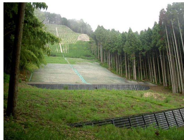
■ 治山施設により整備(輪島市)
