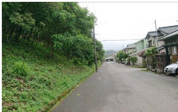
田上地区（図左が整備箇所であり、住宅地に近接している）
