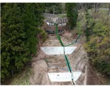
山腹崩壊の復旧 (金沢市小菱池町地内)
