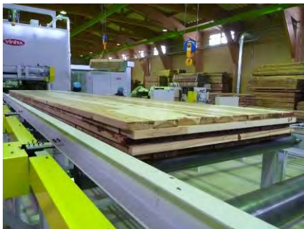
CLT 生産施設
