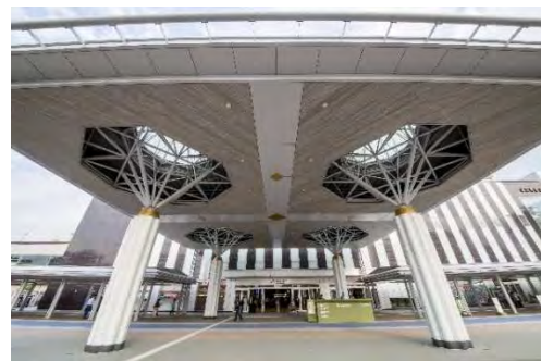
不燃木材を天井に採用した駅エントランス
