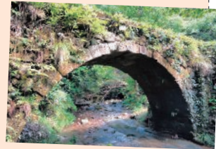
明治後期に作られたアーチ型の石橋
