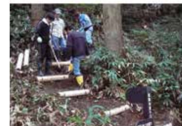
階段・ロープ手すりの設置
