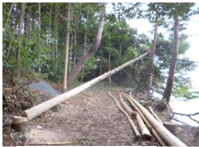
きらめ樹材伐倒の様子
