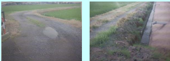
施工前の様子
