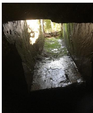
復活させた珪藻土の坑道
