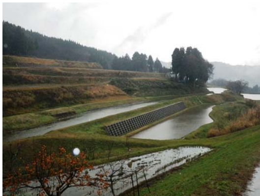
【冬期湛水の様子】
