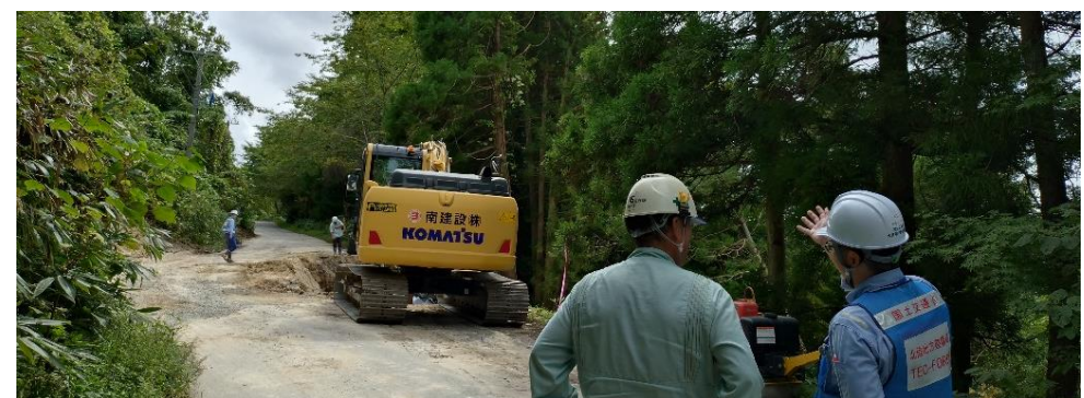
道路啓開班 (珠州市)
