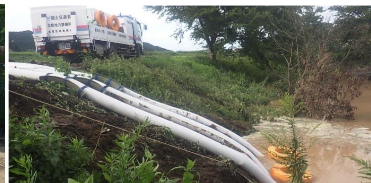
排水ポンプ車派遣 (輪島市)
