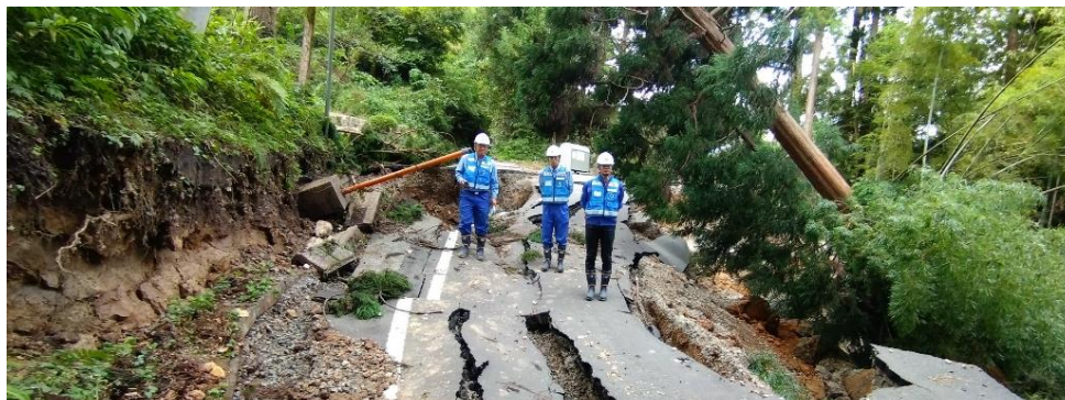
道路啓開班 (珠州市)
