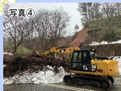
1月3日時点の作業状況 (珠洲道路)
