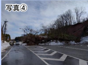
片側交互通行により普通車は通行可
