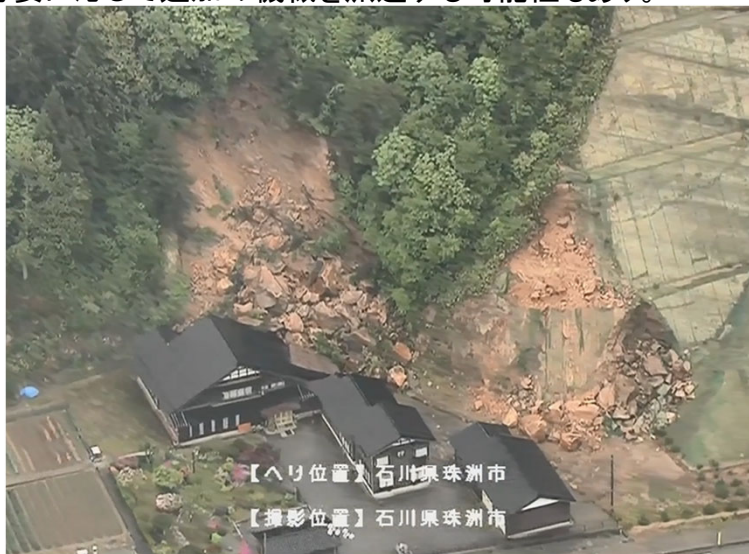
がけ崩れの状況(珠洲市正院町岡田)
