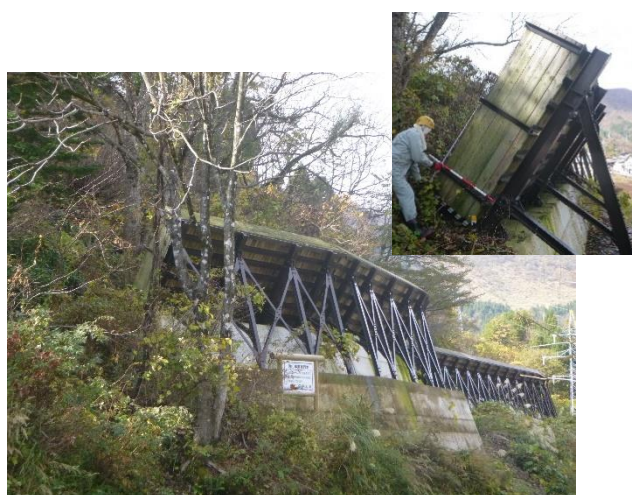
写真1 落石防護柵工 (白山市瀬戸野)
