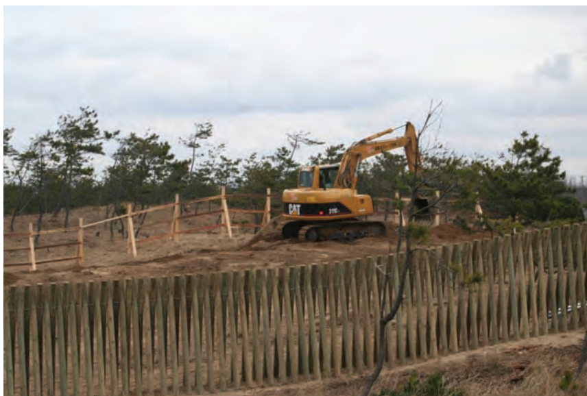
写真-10. 重機による地拵え
