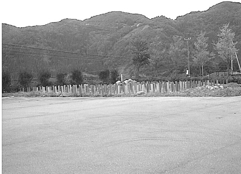
石川ウッドセンター地内における木製杭埋設耐朽試験 ACQ,CUAZ,NZN,銅・シプロコナゾール,無処理の各試験体
