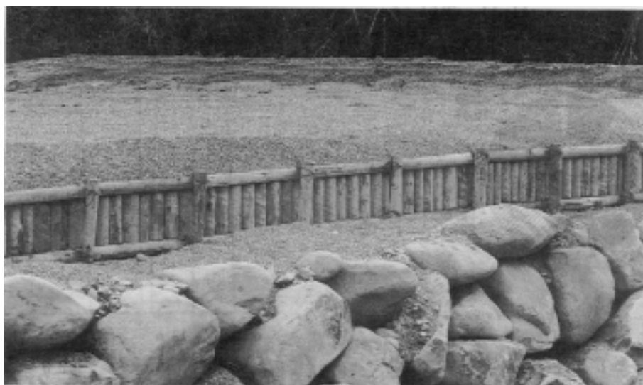
写真3-1 間伐材活用土木施設の例（木柵工）
