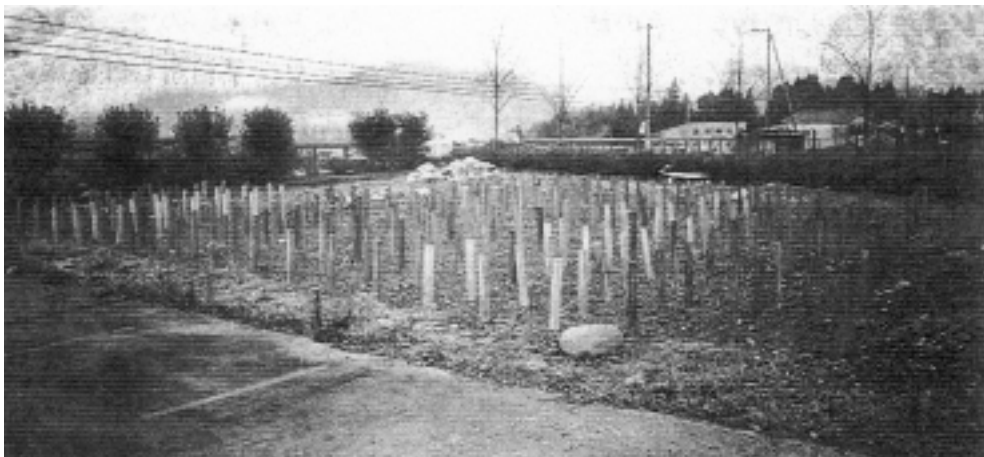
写真3-2 石川ウッドセンターにおける杭埋設試験
