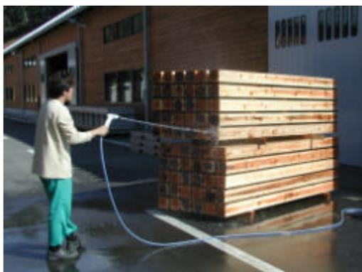
特に高温乾燥の場合、製材後、直ちに（できるだけ生状態で）乾燥を実施することが望まれます。すぐに乾燥できない場合は、製材品をシートで覆う、材に散水する等、材の水分蒸発を防ぐことが表面割れの抑制（乾燥材の品質向上）につながります。
