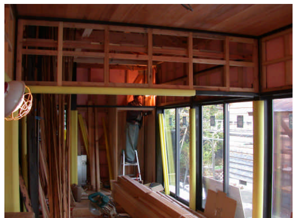
同左内装工事状況
