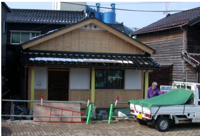
建築中のふるさとモデル住宅（輪島市河井町）
