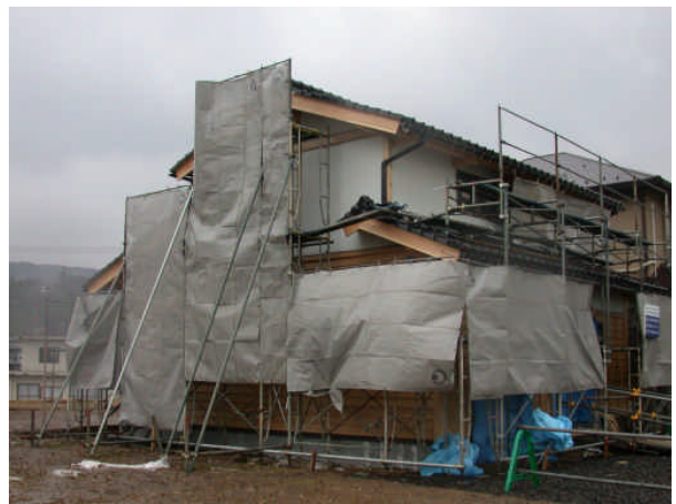
建築中のふるさとモデル住宅（輪島市門前町道下）
