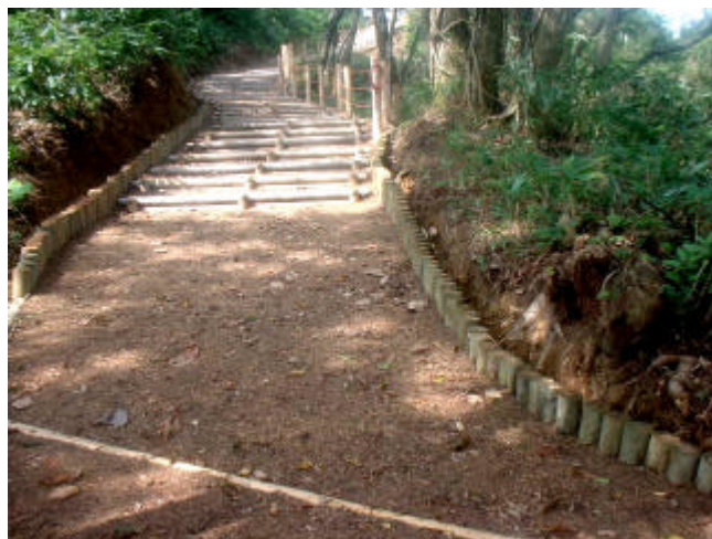
修景連杭施工例
