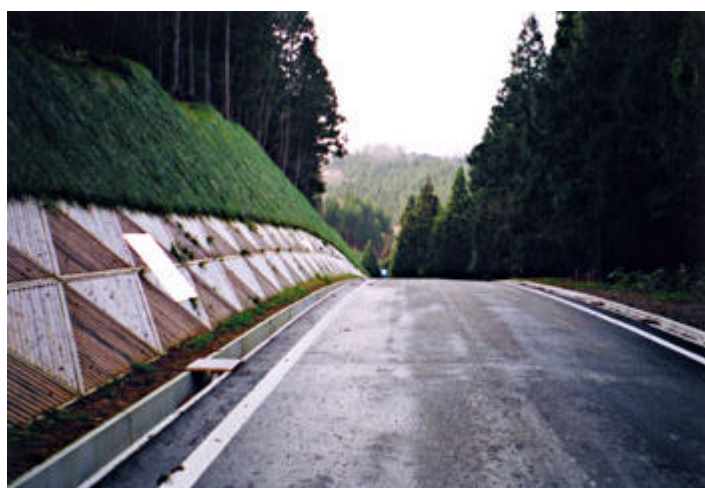
法面保護工（防草パネル）施工例
